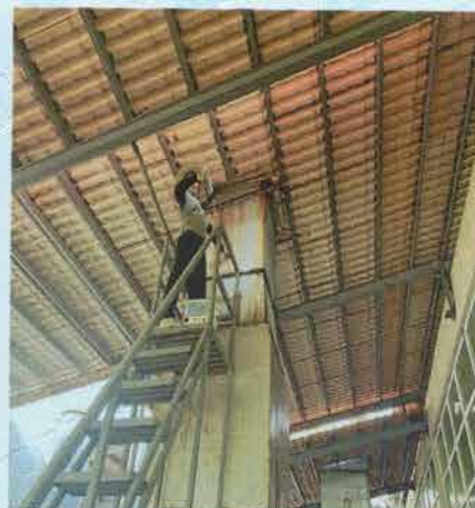
DA018 废气处理后采样口
