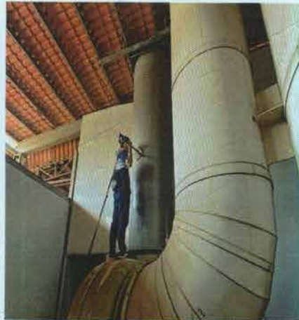
DA002 废气处理后采样口
