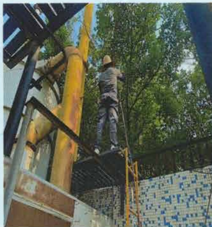
DA030 废气处理后采样口
