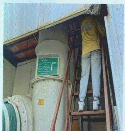
DA007 废气处理后采样口
