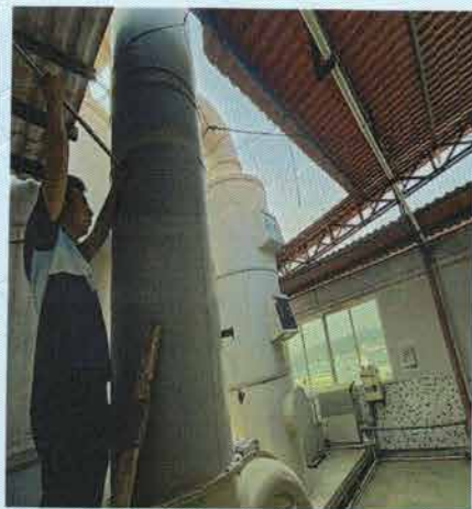
DA012 废气处理后采样口
