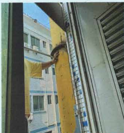
DA029 废气处理后采样口
