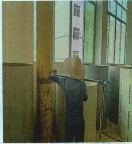
DA024 废气处理后采样口
