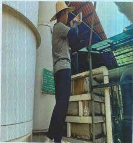
DA004 废气处理后采样口
