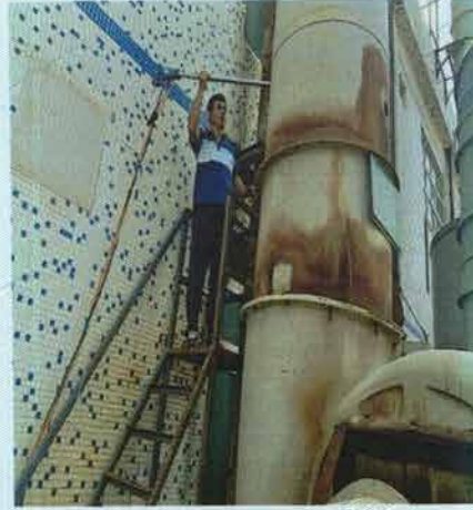
DA021 废气处理后采样口
