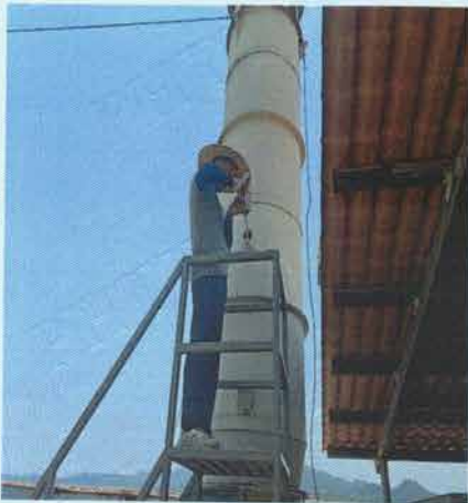
DA017 废气处理后采样口
